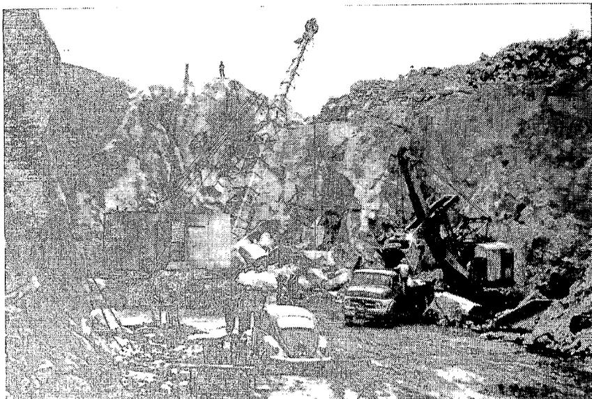
Obras do porto de pesca — Nas pedreiras da Cova do Coelho são cortados enormes blocos de pedra que se destinam ao enrocamento dos molhes.
