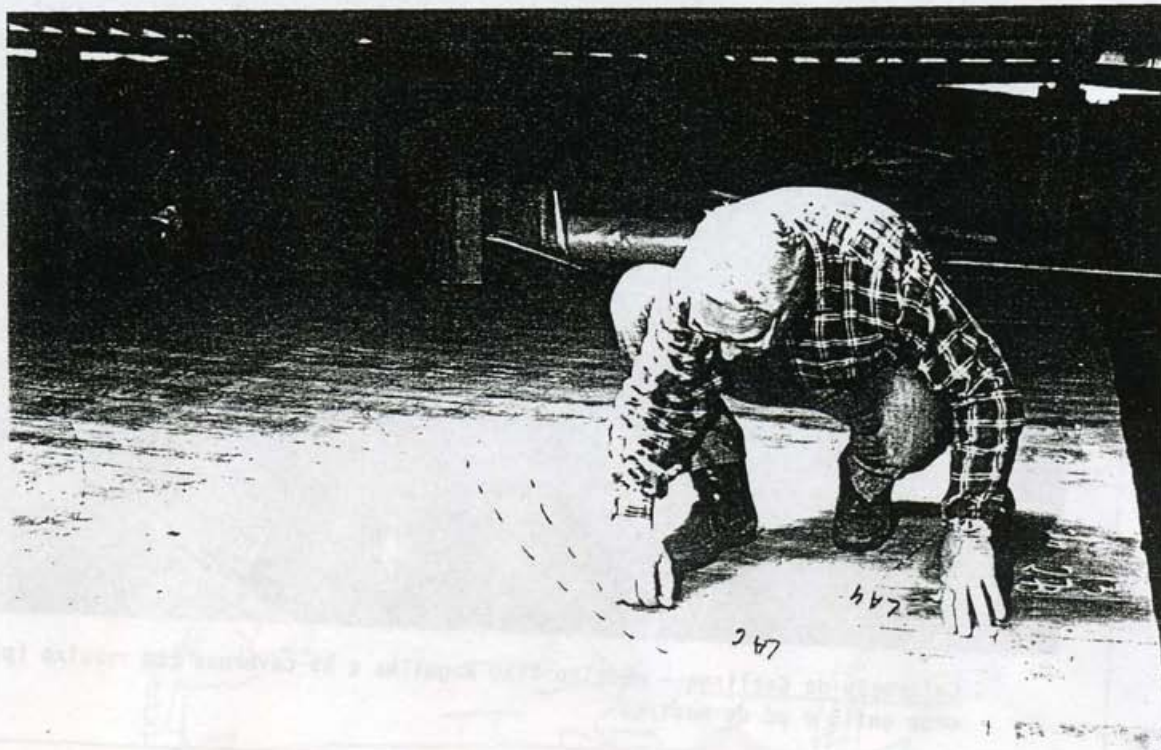
2 - Janeiro / Tracagem das Cavernas na Sala do Risco
