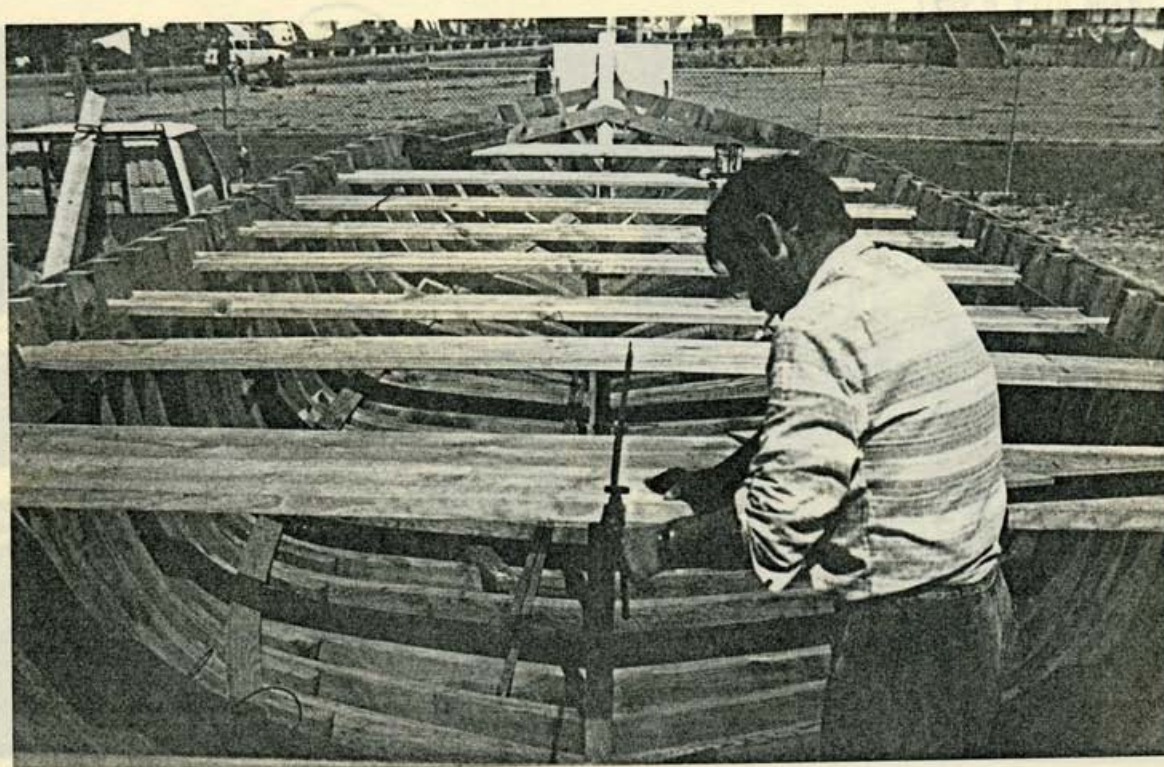
4 - Maio / Colocação das bancadas , que servem de assento para os remadores
