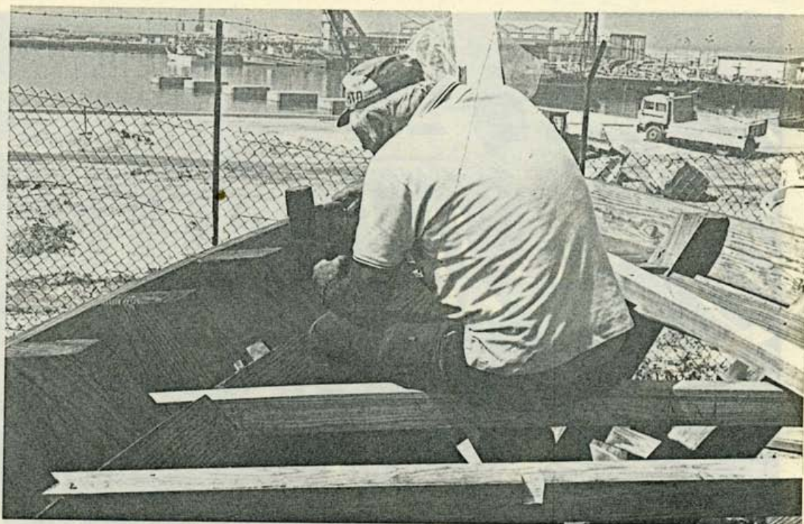
5 - Maio / Abertura dos encaixes para firmar os vaus que sustentam o leito da proa
