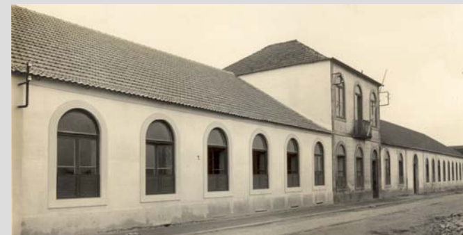
Liceu Nacional Eça de Queirós, no edifício da antiga Fábrica do Gás, 1965.
